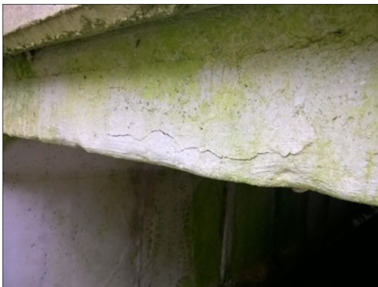
Trhliny na lici na vtokovém čele
