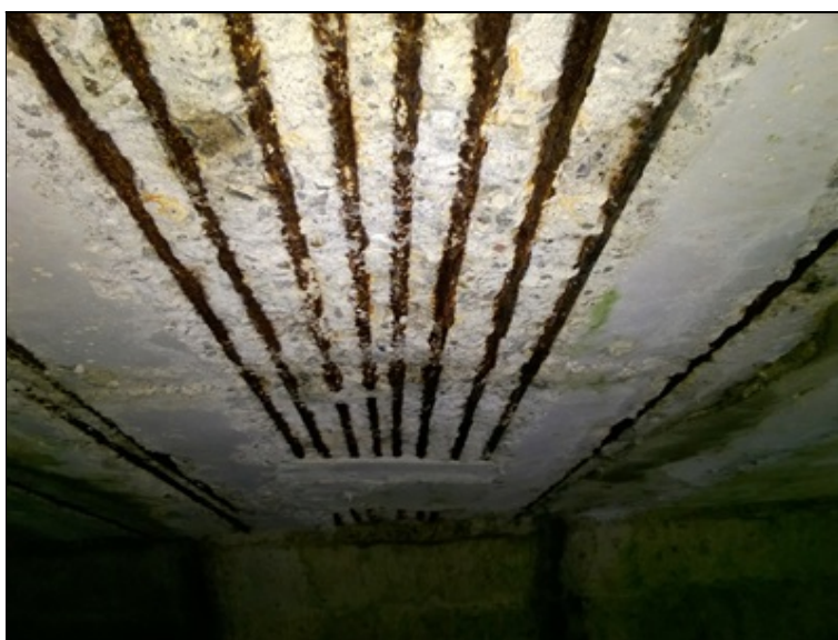
Odpad krycí vrstvy a koroze odhalené výztuže na pohledu NK
