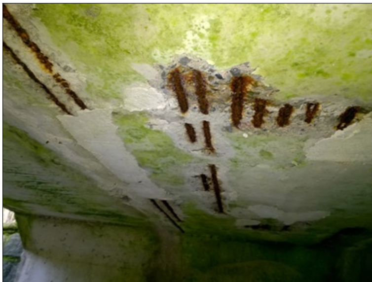
Odpad krycí vrstvy a koroze odhalené výztuže na pohledu NK
