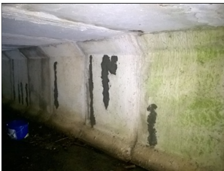
Lokální opravy na lici prefabrikátů
